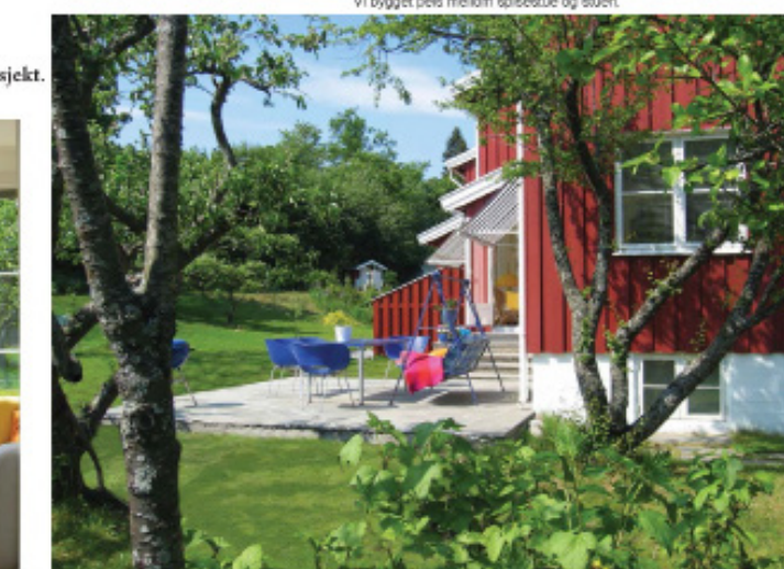
Støpt betongstøle for terrasse.
